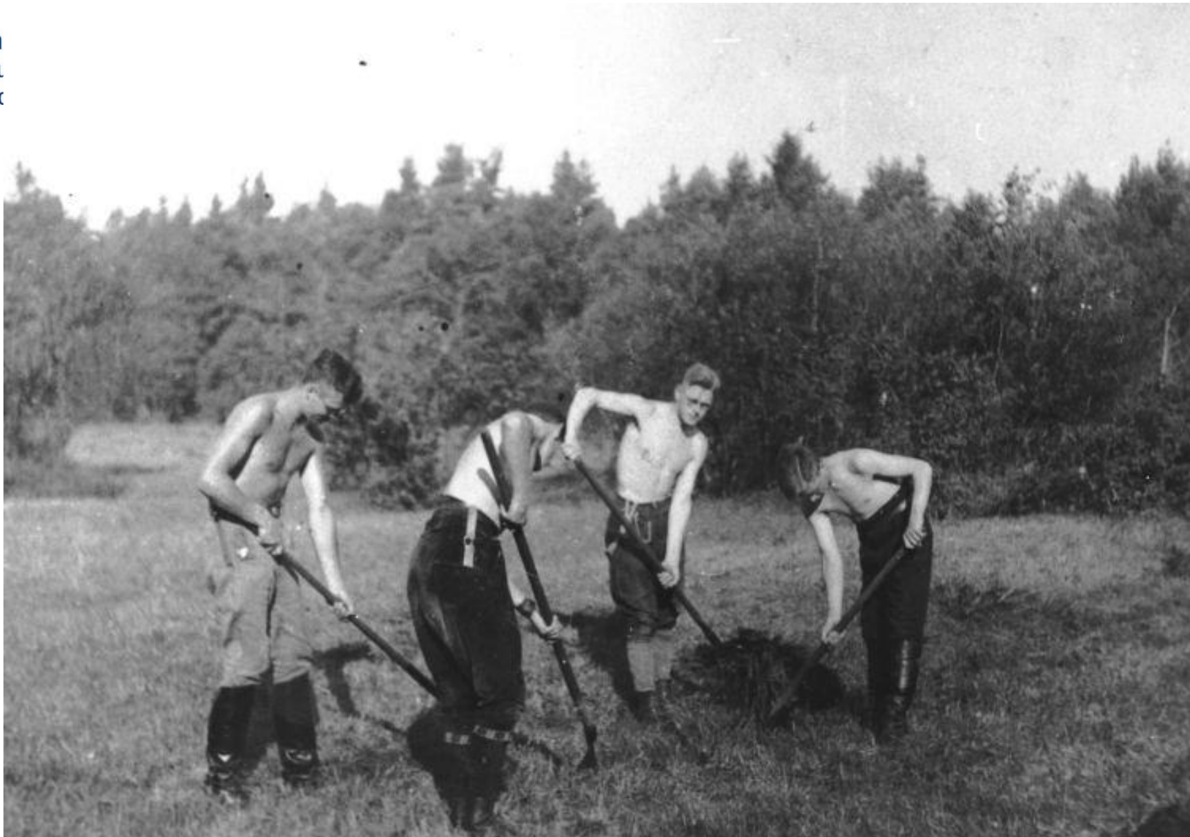
Schüler beim Aufschneiden und Räumen der Bewässerungsrinnen mit dem Suderburger Wiesenmesser auf der Versuchsfläche der Wiesenbauschule um 1930 (KHG, Aufnahme Wilhelm Bosse, Sammlung Baumgarten, Museumsdorf Hösseringen)
