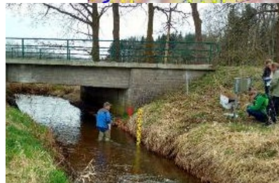
Meßstelle Emern mit Versorgungsstation am Ufer
