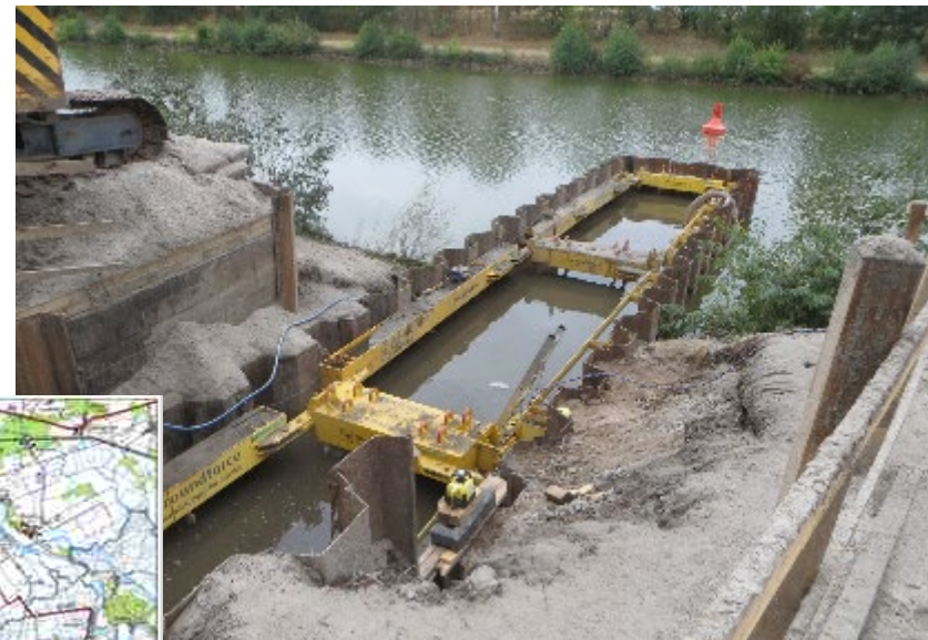
Entnahmebauwerk Beregnungsverband Lüder
