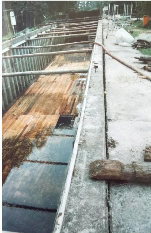
Abbildung 4: Hauptinstandsetzung Schleuse Hakenberg [1994]
