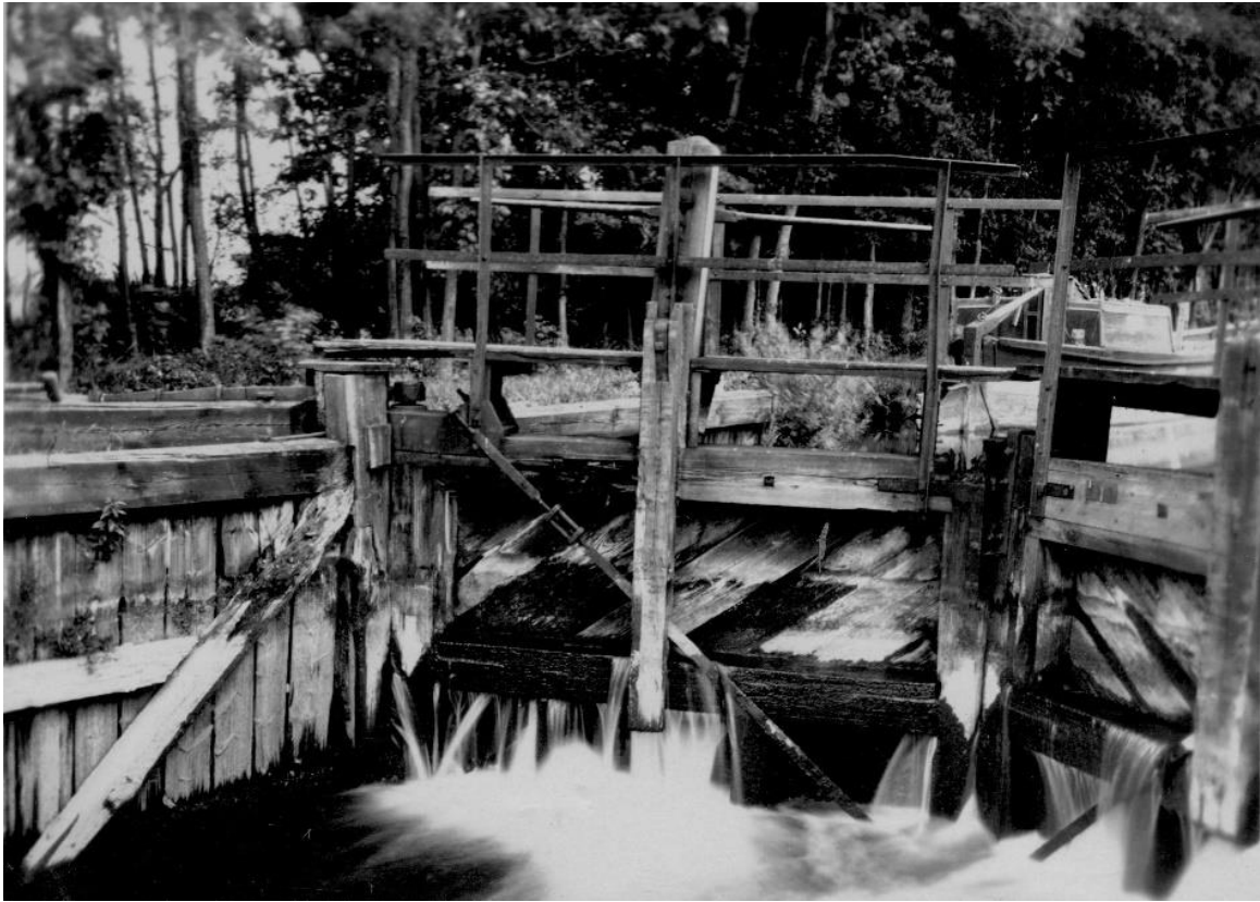
Abbildung 2: Alte Holzschleuse Hakenberg, Schleusentor, Oberhaupt [1926]
