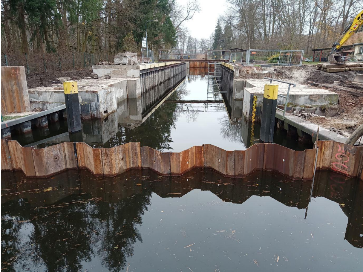
Abbildung 6: Instandsetzung Schleuse Hakenberg [11/2021]
